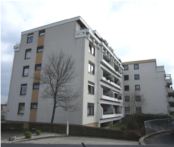
Abb. 22: Geschosswohnungsbau in der St.-Mauritius-Straße
