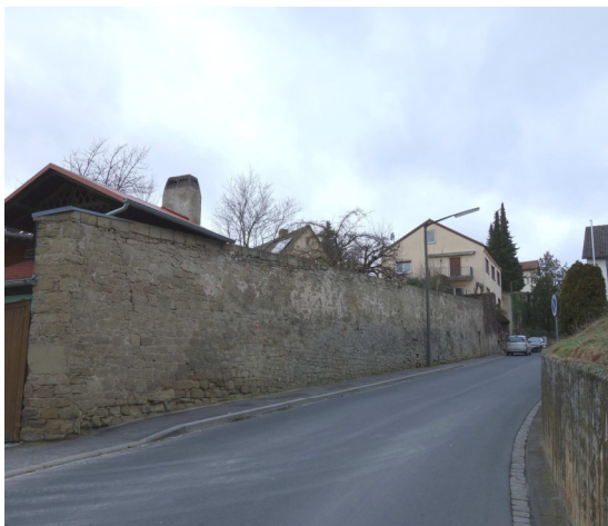
Abb. 45: Schmale oder fehlende Gehwege bergen ein erhöhtes Sicherheitsrisiko für Fußgänger
