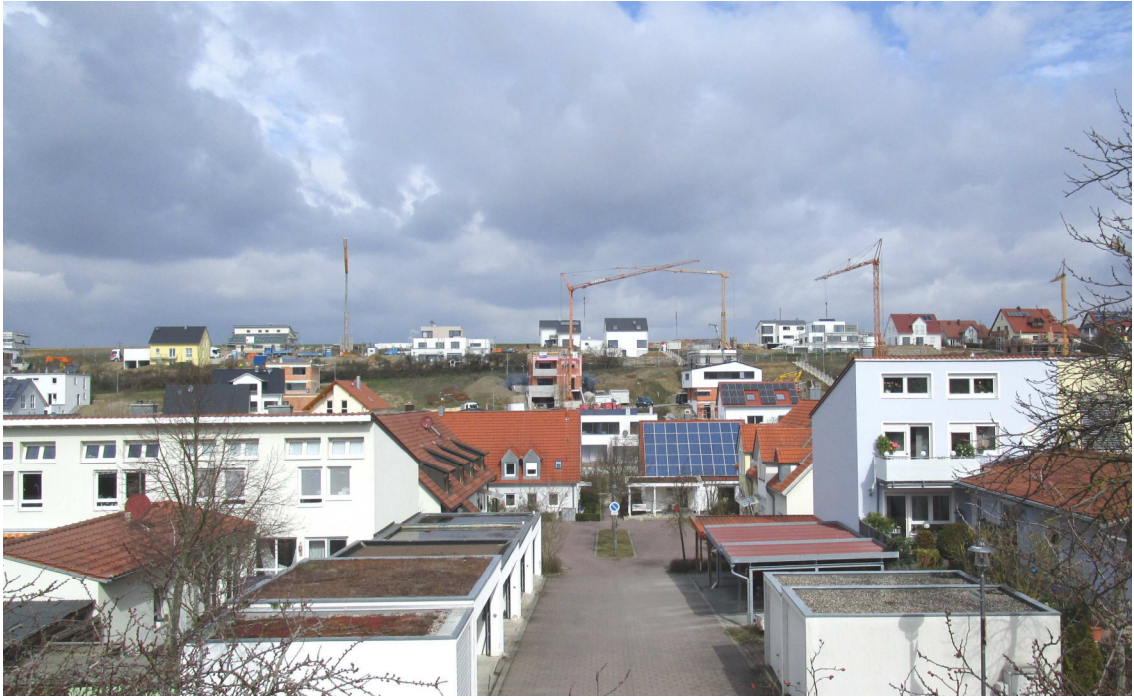
Abb. 38: Bauboom in der Neubausiedlung Am Triebweg
