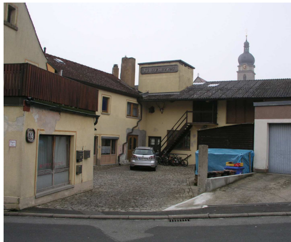
Abb. 46: Fehlende Instandhaltungsmaßnahmen infolge von Leerstand
