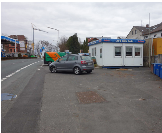
Abb. 43: Städtebaulich diffuse und unattraktive Situation an der Würzburger Straße
