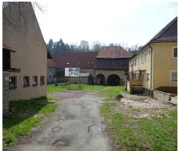
Abb. 29: Kartause mit dringendem Sanierungsbedarf, Untere Ritterstraße 38/40
